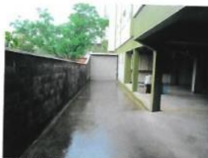
6 Acesso à garagem
