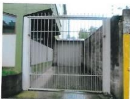
5 Acesso de veículos
