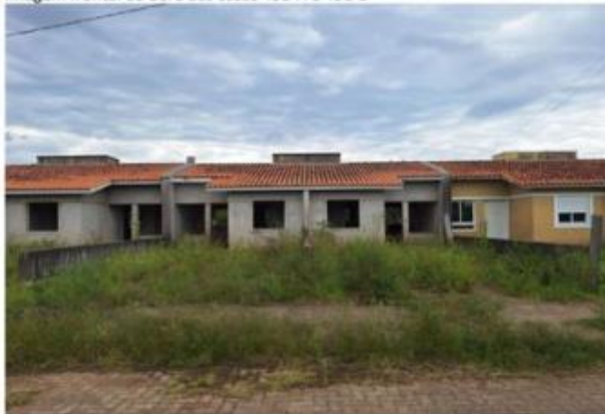
Imagem frontal da obra das casas 451-A e 451-B
