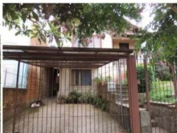
FOTO 02 – Acesso de veículos e pedestres
