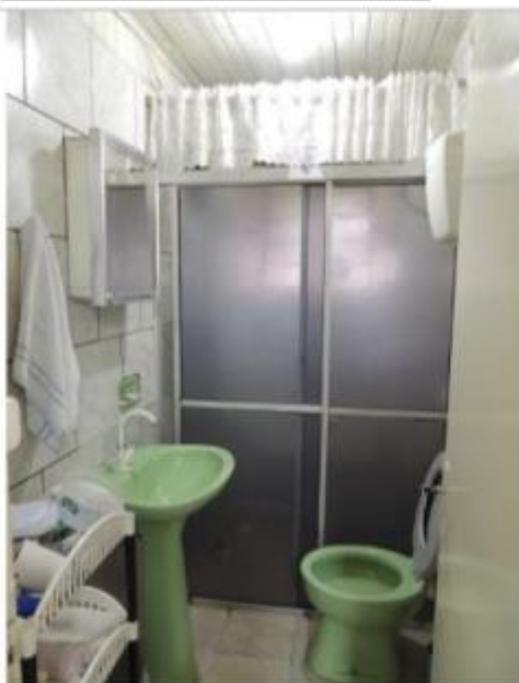
FOTO 13 – Casa inferior – banheiro
